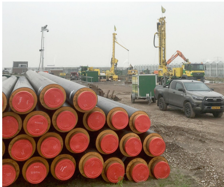
Boorwerkzaamheden voor het geothermieproject Trias Westland, met op de voorgrond de boorinstallatie waarmee het bodemonderzoek voor de HTO haalbaarheidsstudie is uitgevoerd
